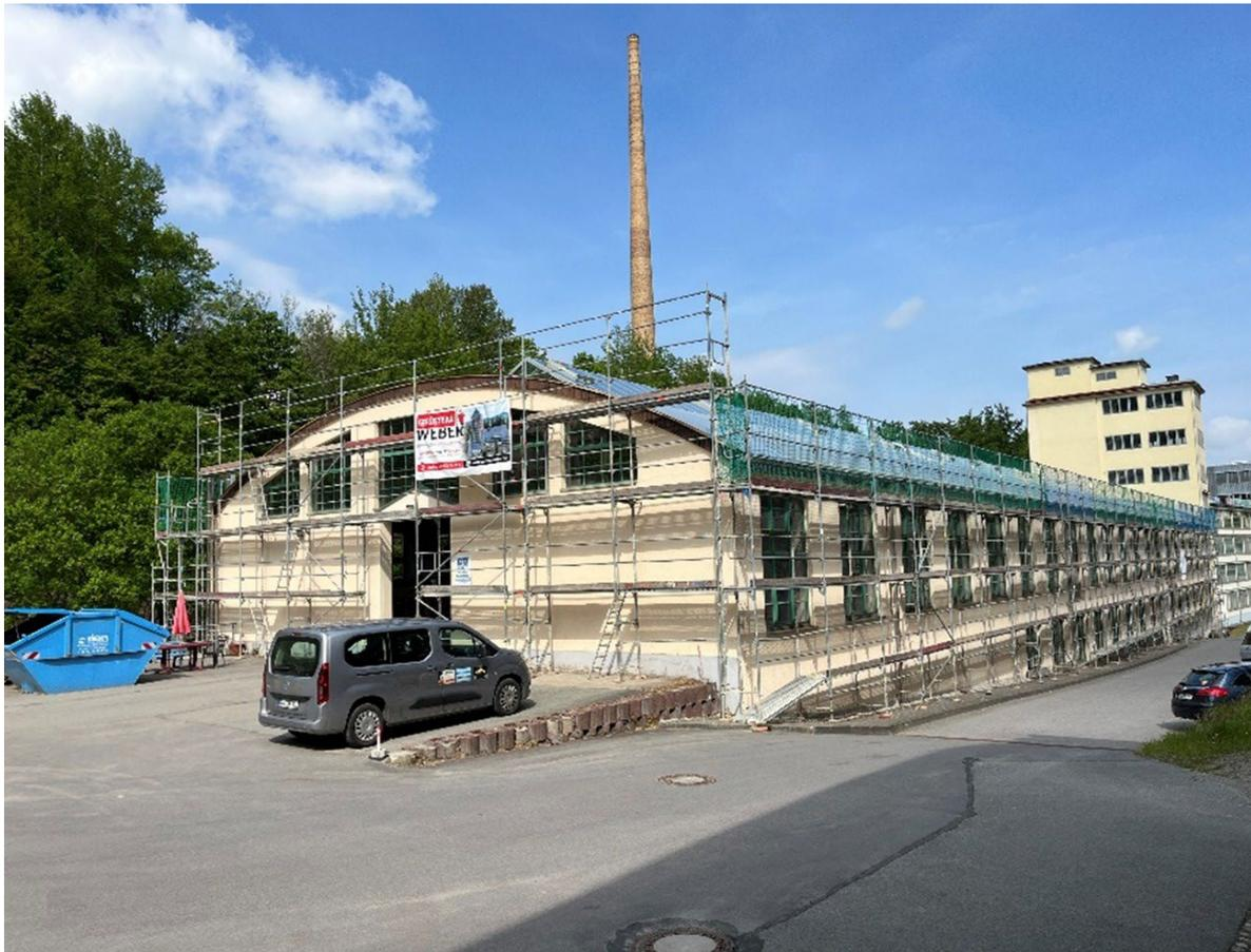
Aufgrund einer Dachneigung von über 30° kam eine speziell für hohe Dachneigungen entwickelte Dachabdichtungsbahn zum Einsatz: die Rhepanol hfk-bs.
