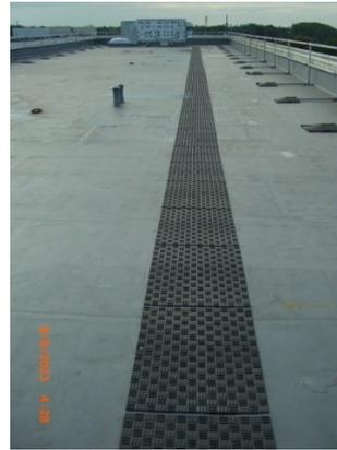
So konnte durch den Einsatz von passendem FDT System Zubehör das noch funktionsfähige Entwässerungssystem ebenfalls ohne Abriss, kostengünstig und umweltschonend in die neue Dachabdichtung integriert werden.
