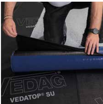
Bild 4: Unterseitenfolie lösen und umschlagen.
