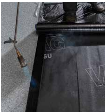
Bild 5: Auf die umgeschlagene Unterseitenfolie stellen, die Längsnaht thermisch aktivieren ...
