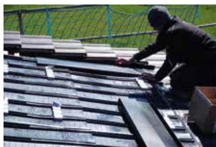
Bild 4: An den Seiten kommen Anschlussbleche zum Einsatz
