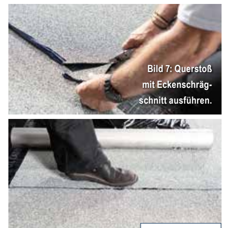
Bild 8 (Verlegung): Querstoß verschweißen und flächig andrücken.
