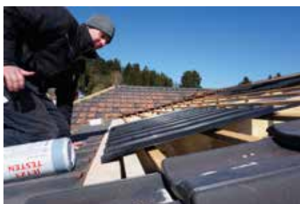
Bild 3: Der traufseitige Anschluss der Intersole wird mit einem Universal-Anschlussband realisiert
