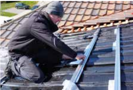
Bild 7: Dann werden die Mikro-Wechselrichter montiert.
