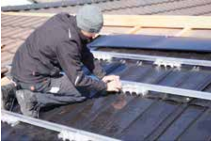
Bild 6: Die Schienen werden montiert und ausgerichtet.
