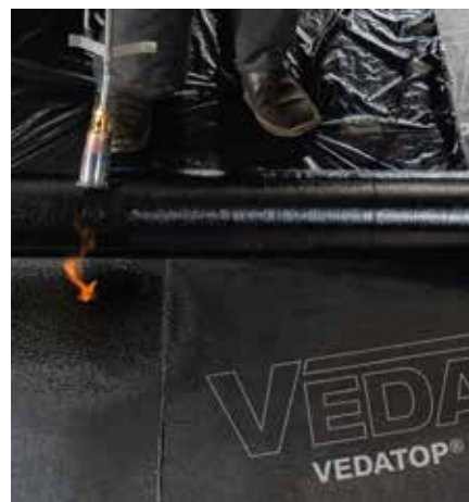
Bild 6: ... und dann die Bahn durch gitternetzartiges Aufbrechen der Oberseitenfolie der Unterlagsbahn thermisch aktivieren.
