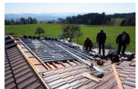
Bild 5: Nachdem die Anker gesetzt wurden, können die Schienen montiert werden.
